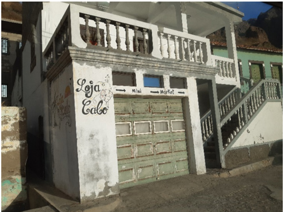
Figura 16: Mercearia local. (Fotografia equipa consultora, março 2024)
