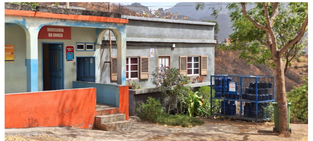
Figura 17: Merceria da Graça. Uma das casas escolhida para albergar turistas-localizada em Água das Patas. Fotografia da equipa consultora.
