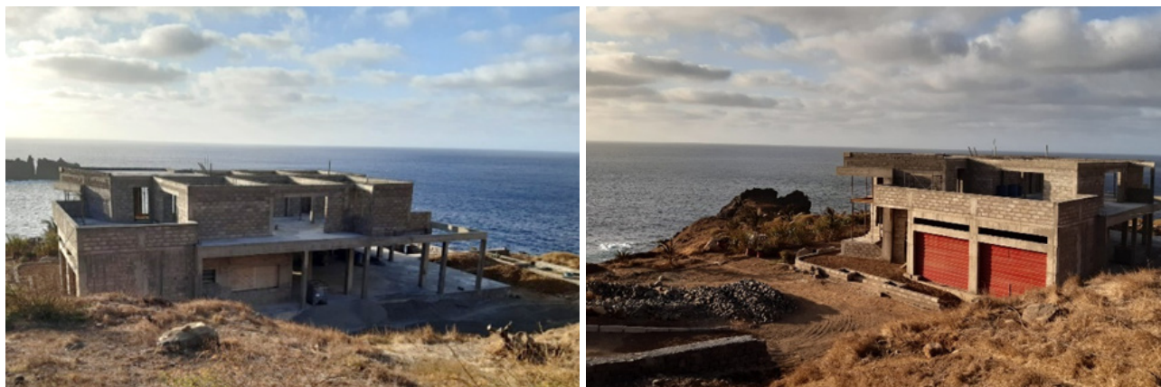
Figura 15: Novo hotel em construção junto às piscinas naturais em Fajã d'Água (Fotografia da equipa de consultoria, março de 2024).
