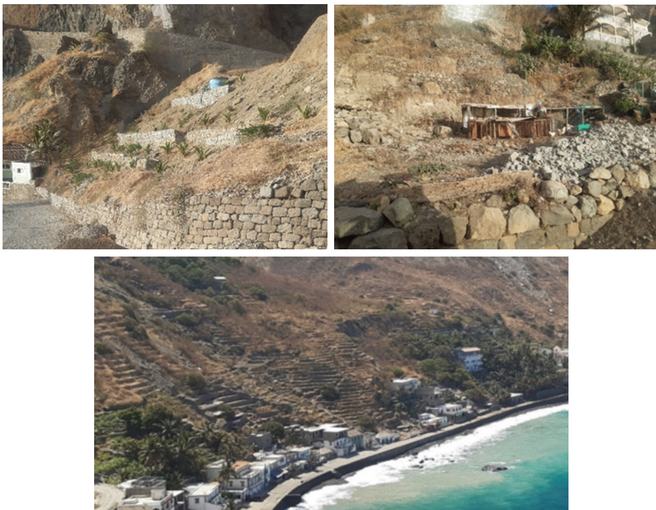
Figura 28: Terraços para conservação do solo e água (CSA) nas encostas em Fajã d'Água. (Fotografia da equipa consultora, março 2024).
