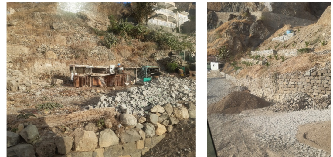
Construção em encostas com risco de movimentos de terra
