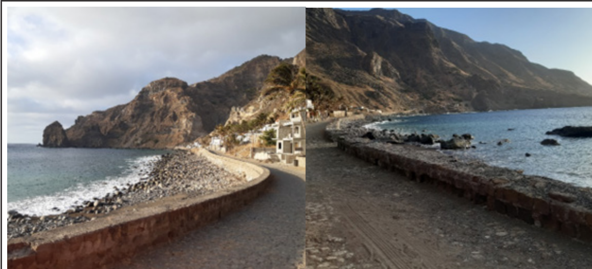
Muro de contenção contra a subida do nível do mar
